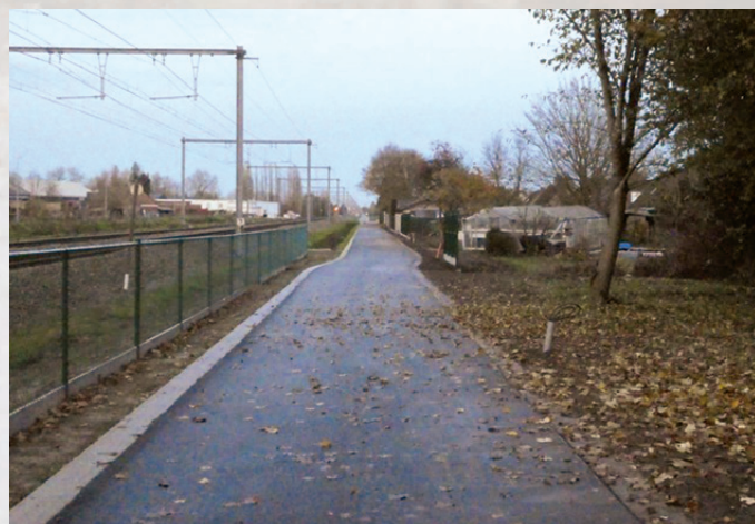
De fietssnelweg langs het spoor.
